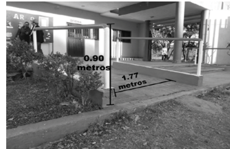
Fotografía 2. Medidas reales, barras de apoyo institución primaria.
