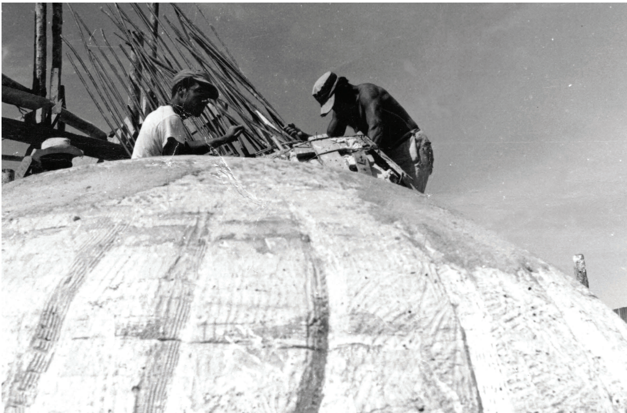
Armado y colado de la estructura. Fotografía: AHFCJ.
