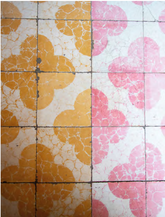
Detalle de mosaicos del piso tipo tapete, de la habitación
