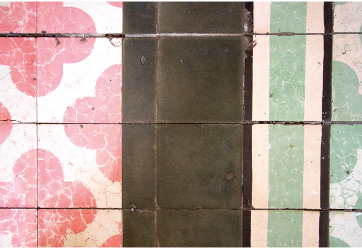
Detalle de mosaicos del piso tipo tapete, de la habitación
