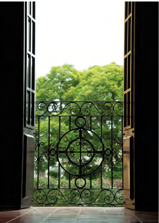
Balcón con detalle de la herrería original de la casa
